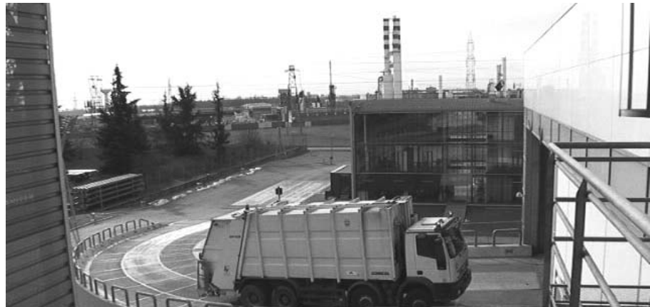
Termovalorizzatore, nuova presa di posizione per la sua costruzione [foto Calvaresi]
